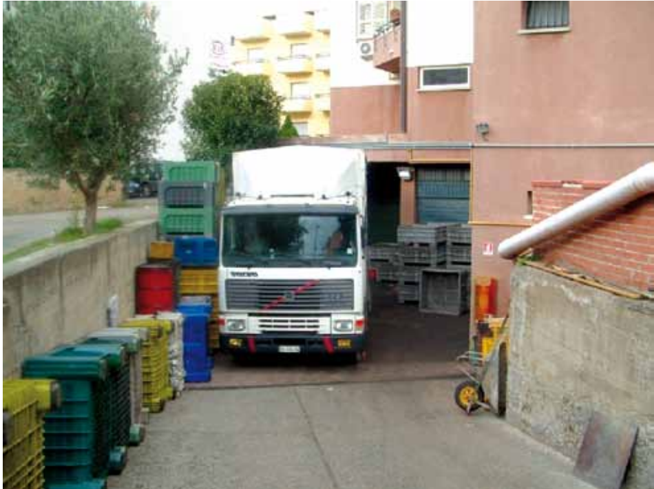
Figura 2 – Frantoio localizzato in un centro abitato ad alta densità residenziale. Notare gli esigui spazi di manovra
