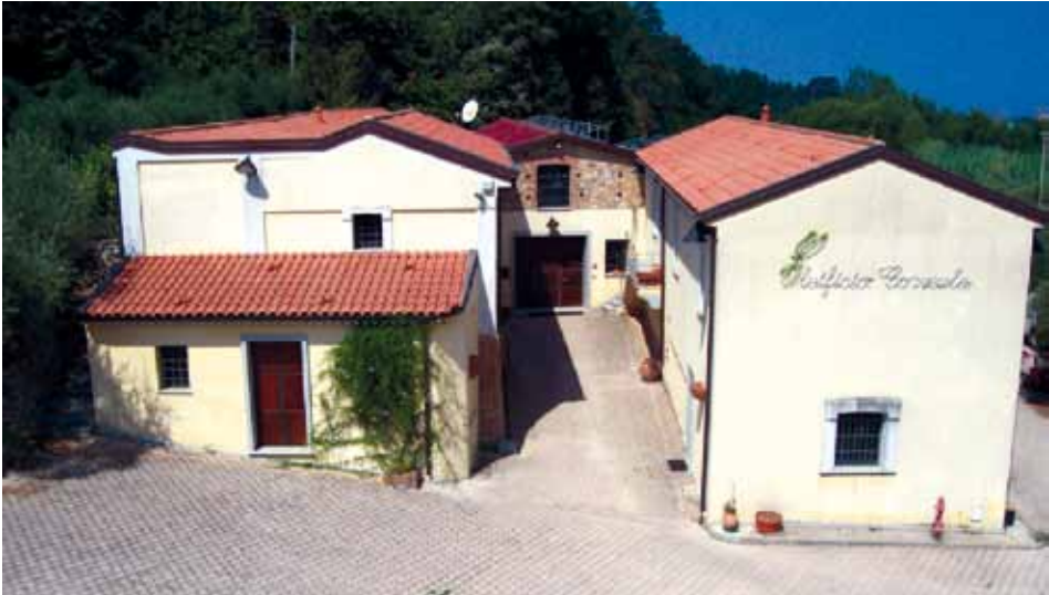
Figura 1 – Scorcio di un frantoio che si affaccia su una strada provinciale
