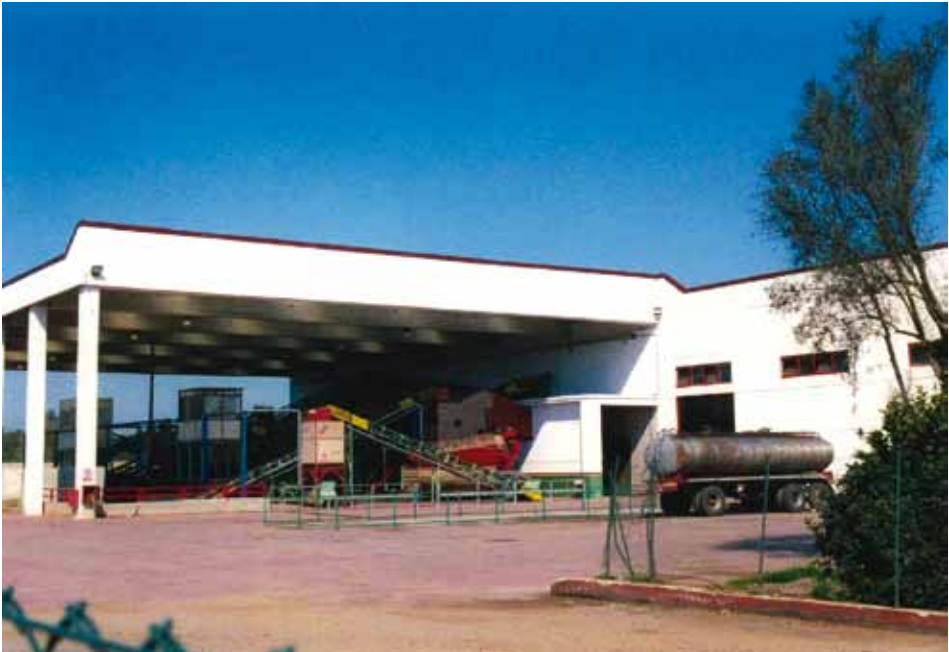
Figura 4 – Tettoia sopra vasca di scarico delle olive
