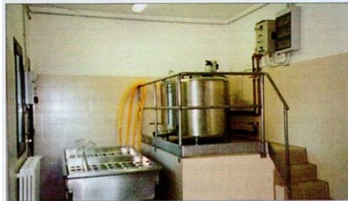
Fig. 8.13 – Sistemazione impiantistica di un minicaseificio con due caldaie da 200 lt accoppiate e gruppo produzione vapore separato: si notino i tavoli a doppio fondo che accolgono gli stampi.
