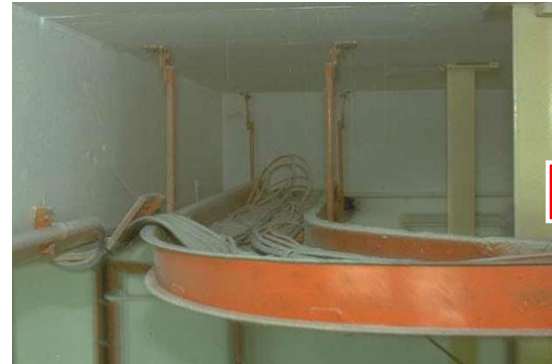
ACCUMULO DI POLVERE SU CANALINA IMPIANTO ELETTRICO
