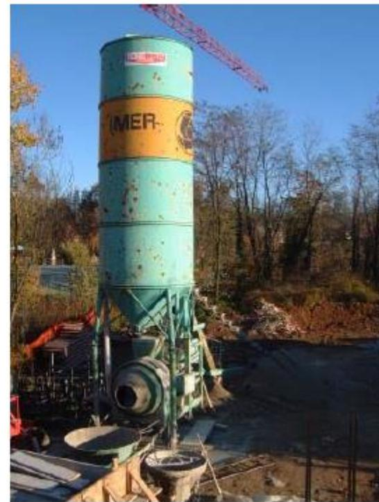
**Centrale di betonaggio**
