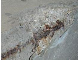
**Esposizione dei ferri di armatura** – cause: errore di progettazione, errore di posa, causa accidentale
