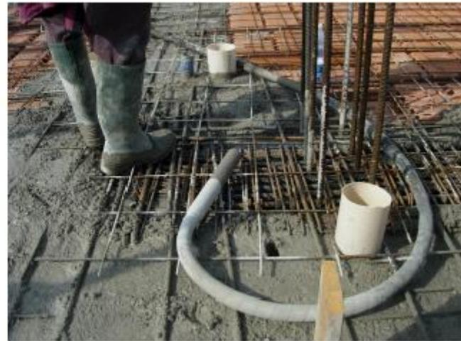
**Costipamento dell'impasto nella cassaforma tramite vibratura**
