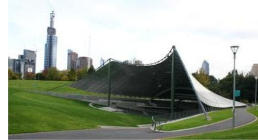
**Strutture a tenda** Per tenda si intende una lamina di materiale talmente sottile da non presentare alcuna resistenza a flessione, compressione, e taglio capace, invece, di reagire solo a trazione. Tale sistema è limitato a strutture provvisorie di piccole dimensioni.
