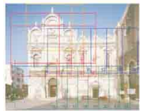
Quadro di unione delle prese fotogrammetriche. Facciata della scala grande di S. Marco
