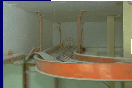
ACCUMULO DI POLVERE SU CANALINA IMPIANTO ELETTRICO
