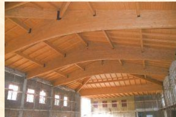
Struttura in lamellare curvato
